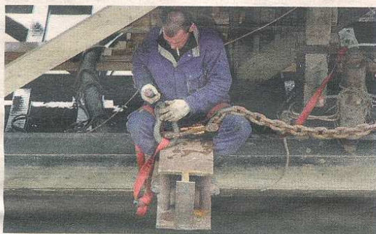
Lundi après midi, il a fallu fixer les cables de treuillage.
